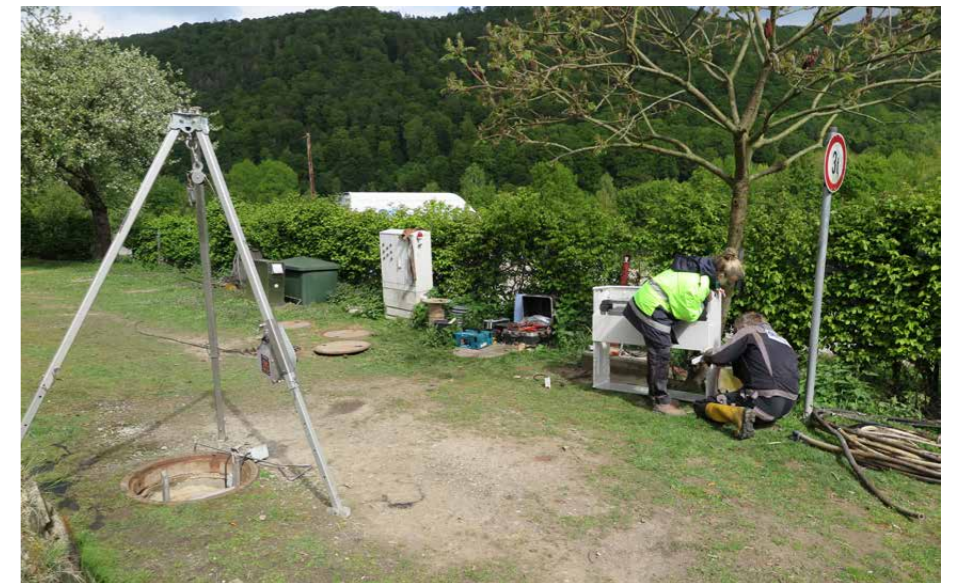
Ob Brunnen, Kläranlage oder Zaun: In Bad Karlshafen gibt es ständig etwas zu reparieren.
