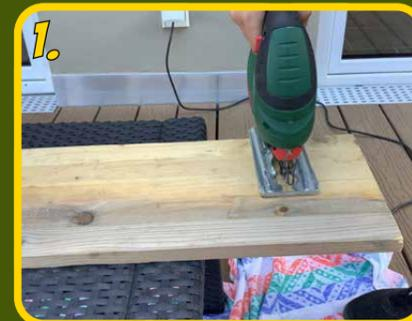
Jetzt sind die Eingänge dran: Die haben wir mit einer Stichsäge an einem der beiden langen Bretter ausgesägt. Sie sind 10 x 10 cm groß.
